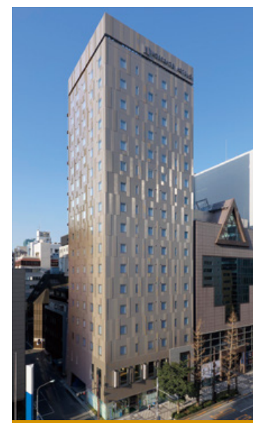
B-1 ホテルインターゲート東京 京橋 東京都中央区
